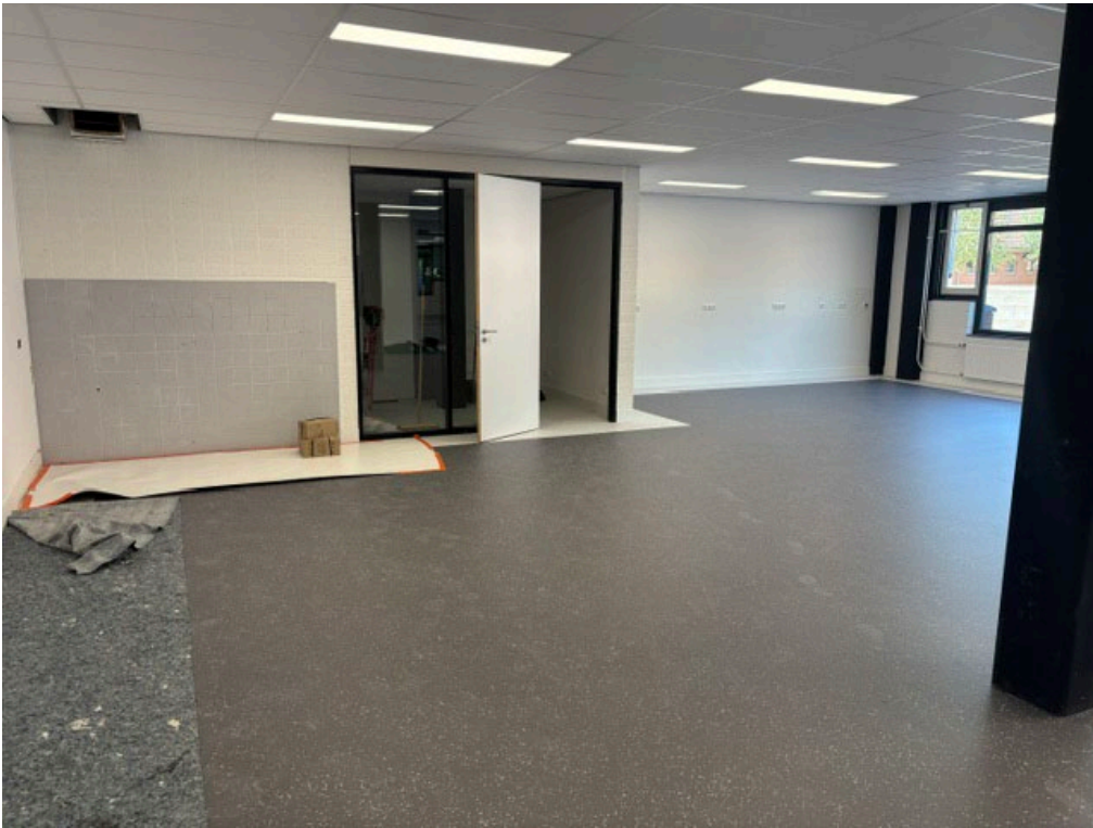
1 van de technieklokalen, de oude tegels zijn ook alsnog aangepast.
