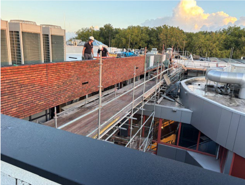
Metselwerk gevel 20-gang is al ver klaar, hierna volgt de glazen pui.
