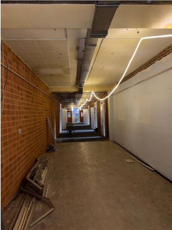
1ste verdieping gang 40-vleugel
