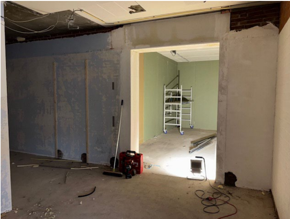
Nieuwe, grotere toiletblokken voor het personeel, waar de latten zitten wordt een deuropening gezaagd.
